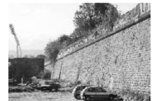
Repart de La Canée après travaux
